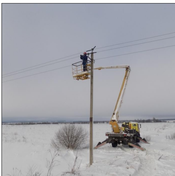
Фото 2. Установка первых птицевозащитных устройств в заказнике «Журавлиная родина» (фото О.С. Гринченко). Photo 2. Bird diverters getting installed for the first time in the “Crane Homeland” Nature Reserve (photo by O.S. Grinchenko).
