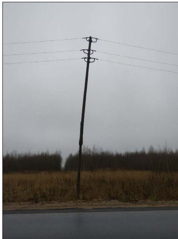
Фото 10. ЛЭП с птицезащитными устройствами (фото Р.Х. Атауллина). Photo 10. Power lines with bird diverters (photo by R.H. Ataullin).
