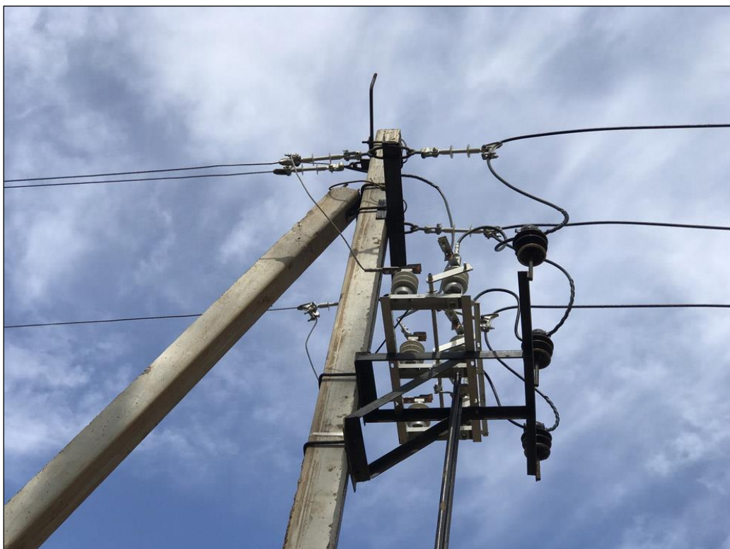
Фото 4. Неизолированные провода, опасные для птиц (фото Р.Х. Атауллина). Photo 4. Uninsulated wires pose a danger for birds (photo by R.H. Ataulin).
